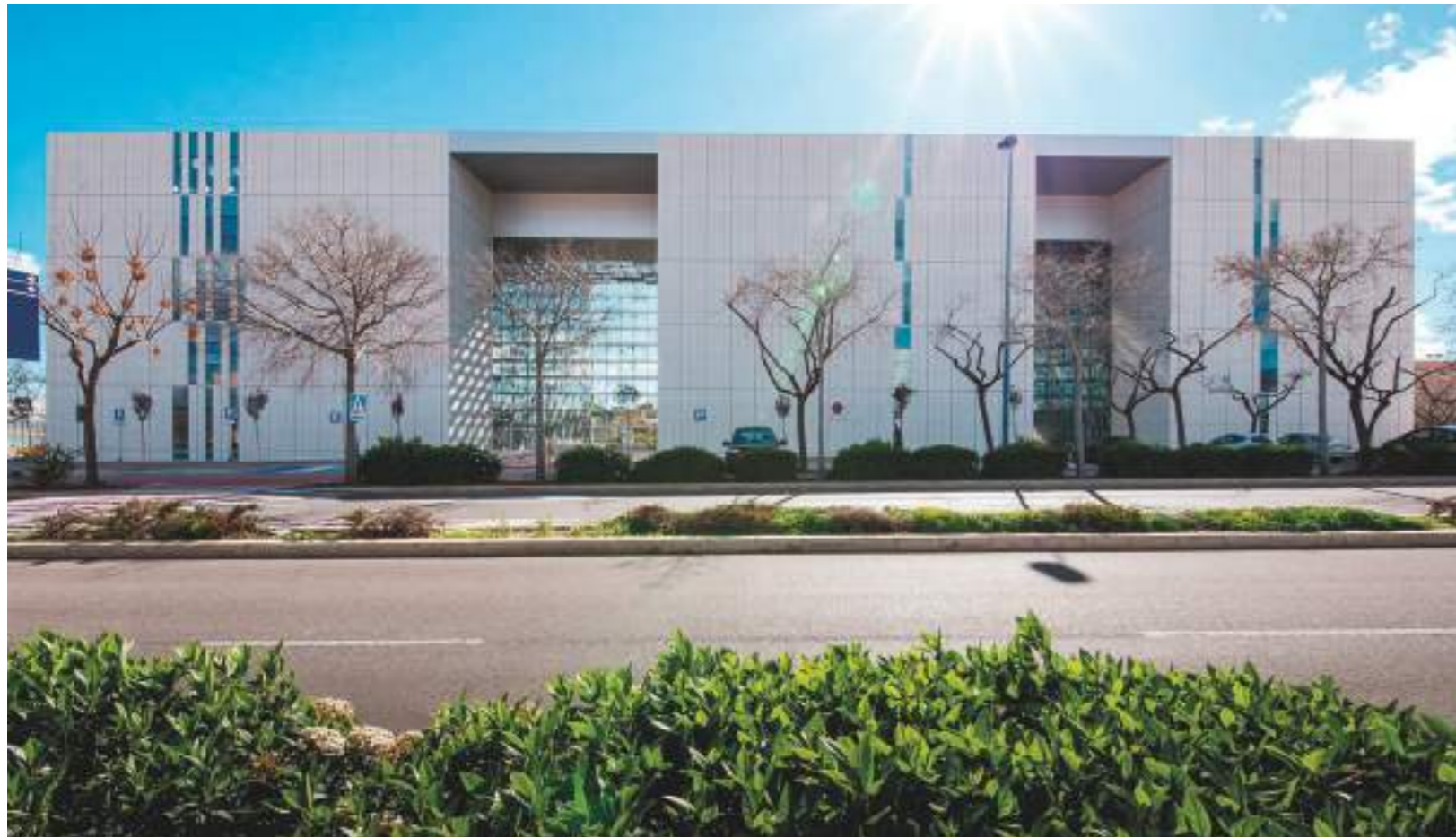
Fachada Facultad Ciencias de la Salud, Castellón 2018.
